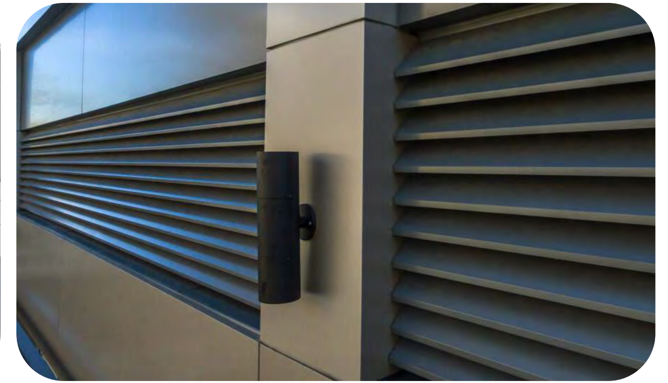
⑧ Metal Louvers
